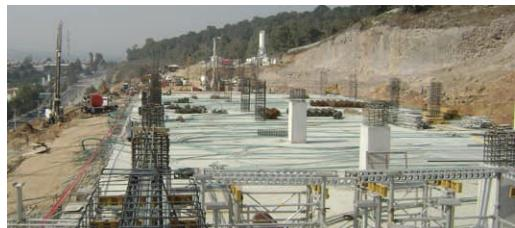
En la Zona Esmeralda en Atizapan de Zaragoza, GIA Construcción está construyendo el Centro Comercial Bosque Esmeralda para lo cual confió a Freyssinet de México los trabajos de diseño de sistema de piso por medio de losas postensadas, así como el servicio de presfuerzo y suministro de caseton de fibra de vidrio.
