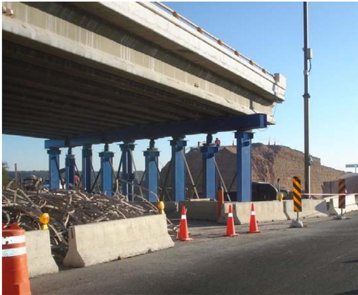
El centro SCT Querétaro a través de la Residencia de Conservación de Carreteras, asignó a Freyssinet de México la reparación del puente Pie de Gallo, ubicado en el Libramiento Norponiente de la Ciudad, esta consistió en la formación de un puntal provisional metálico para izar el puente y poder retirar una de las rampas de acceso.
